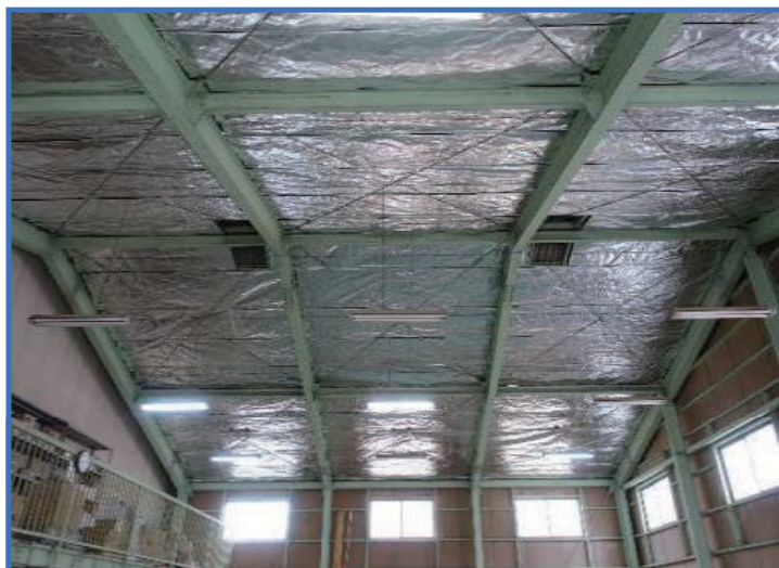
キープサーモ®ウォール施工倉庫
